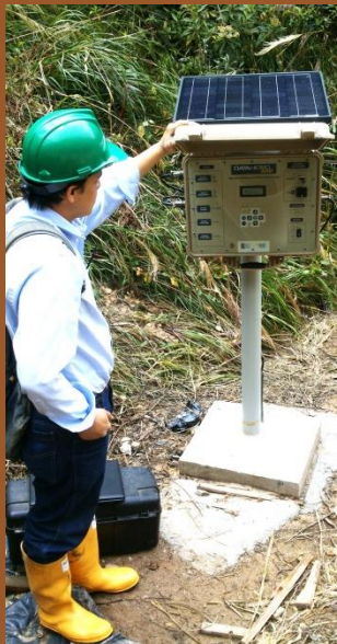
Foto 1. Instalación y operación del equipo
